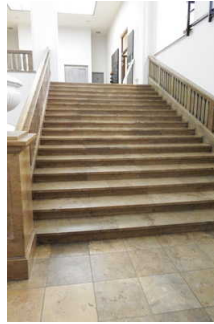
Treppe vom Foyer EG zum 1. OG
