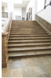
Treppe vom Foyer EG zum 1. OG
