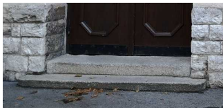
Stufen am Eingang außen (Bestehornhaus mit Veranstaltungssaal)
