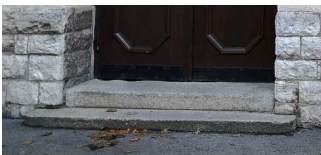
Stufen am Eingang außen (Bestehornhaus mit Veranstaltungssaal)
