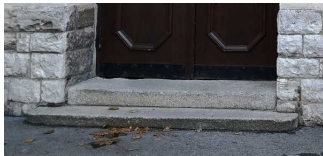
Stufen am Eingang außen (Bestehornhaus mit Veranstaltungssaal)
