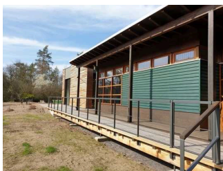
Weg von Eingangstür Außengelände zum Eingang Auenhaus
