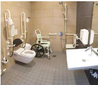
2. WC nahe Aufzug
