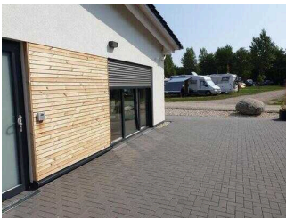
Weg um das Sanitärgebäude 1
