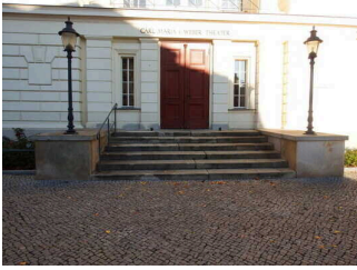
Treppe am Haupteingang
