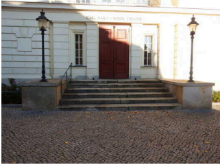
Treppe am Haupteingang
