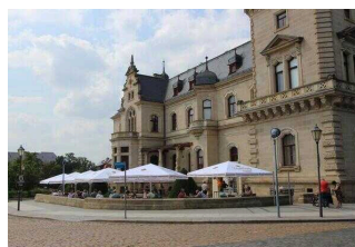
Weg vom Parkplatz zum Genussgarten/ Eingang mit Treppe
