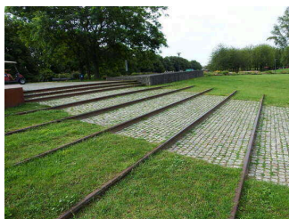
Treppe an der Westseite der Fußgängerbrücke
