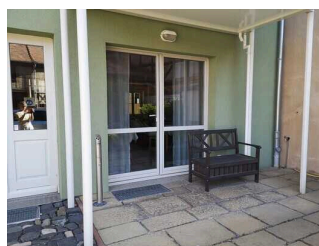
Weg außen vom stufenlosen Nebeneingang zum Eingang Clubraum
