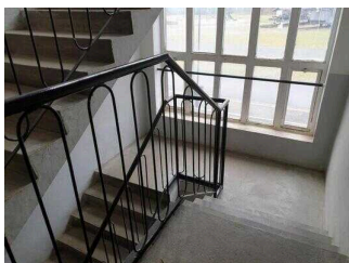
Museumsgebäude: Treppe vom EG ins 2. OG
