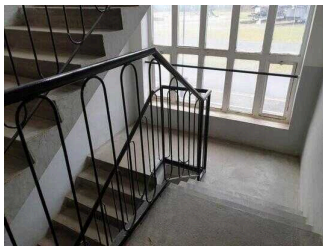
Museumsgebäude: Treppe vom EG ins 2. OG
