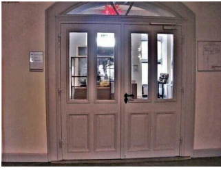
Haus 1: Türen im Historischen Waisenhaus
