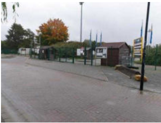
Eingangsbereich Stadion außen
