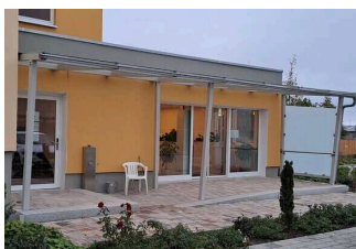
Abgesenkte Stufe am Eingang
