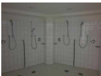
EG: Duschen im Saunabereich
