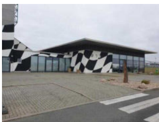
Weg außen vom Parkplatz zum Eingang Tagungsraum "Ferrari"
