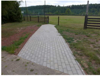
Zugang zum Fußballfeld
