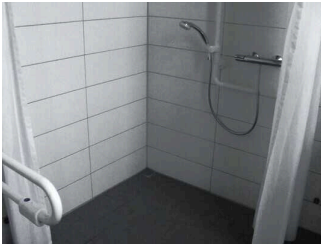
Blick in den bodengleichen Duschbereich.
