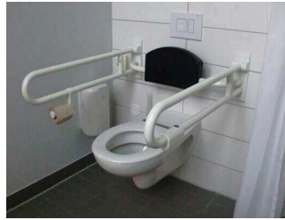
WC-Becken mit Stützklappgriffen und Rückenlehne
