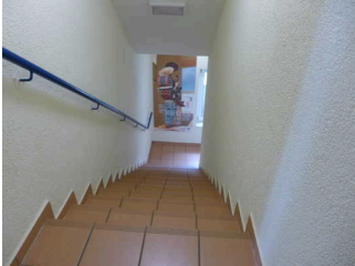
1. Treppenabschnitt vom Erdgeschoss ins Untergeschoss
