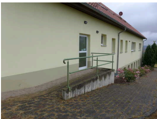
Hintereingang mit Rampe
