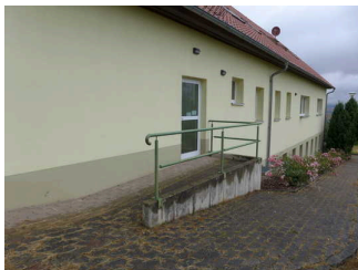
Hintereingang mit Rampe
