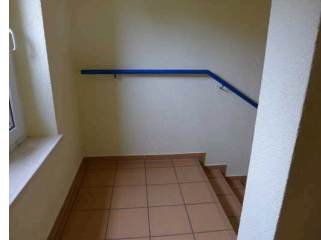
Zwischenfläche Treppe vom Erdgeschoss ins Untergeschoss
