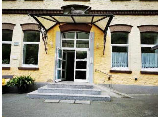
Eingangsbereich mit Rezeption
