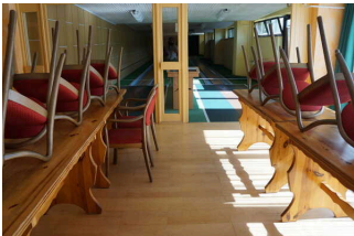
Vorraum zur Kegelbahn
