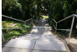
Treppe außen zum Eingang 3. Abschnitt
