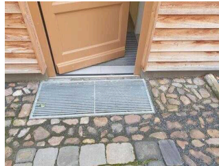
Stufenloser Eingang Klostercafé / gleichzeitig Eingang Sanitärgebäude
