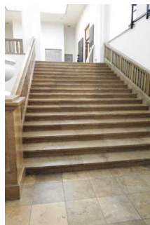
Treppe vom Foyer EG zum 1. OG
