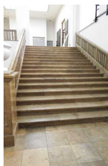
Treppe vom Foyer EG zum 1. OG
