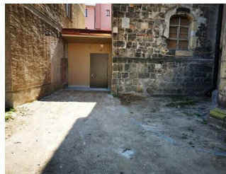
WC am Nebeneingang
