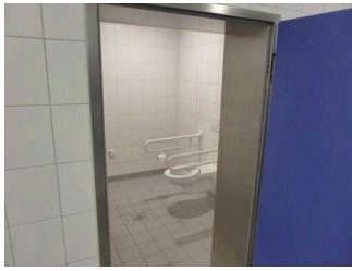
Nebengebäude: Öffentliches WC für Menschen mit Behinderung – Damen im Sole- Bewegungsbad
