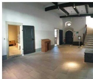
Altbau, EG: Flur
