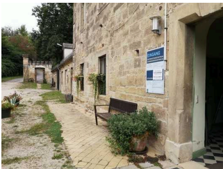
Weg vom Parkplatz zum Infozentrum
