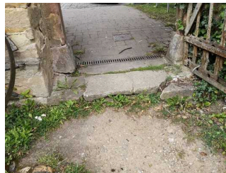
Weg vom Parkplatz zum Infozentrum
