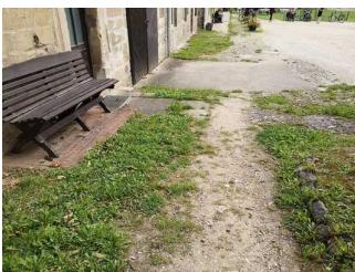
Weg vom Parkplatz zum Infozentrum
