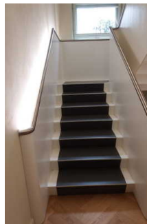
Treppe vom 1. zum 2. OG
