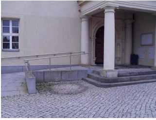
Treppe am Nebeneingang
