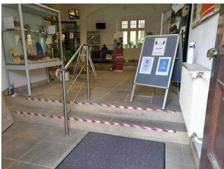
Treppe am Haupteingang (innen)
