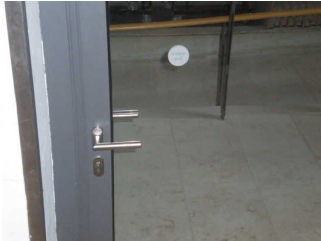
Tür zur Rampe in den Veranstaltungsraum
