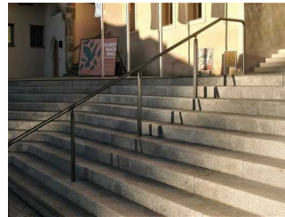
Treppe auf der Freifläche
