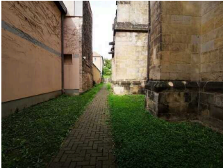
Weg außen von Eingangsbereich zum Nebeneingang
