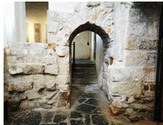
Treppe zur Krypta
