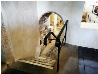
Treppe zur Krypta
