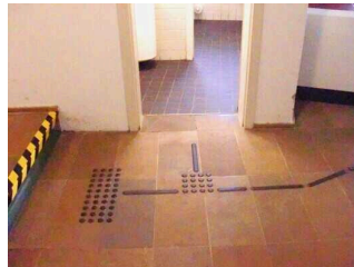
Die Seitenansicht verdeutlicht das Hindernis Einzelstufe. Gut erkennbar ist das Blindenleitsystem. Der Abzweig führt in ein öffentliches WC.
