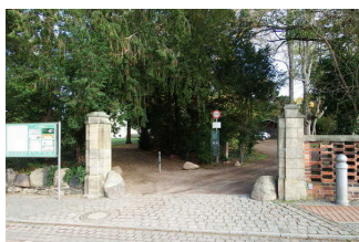
Parkeingang an der Kirchgasse
