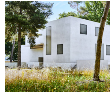
Neue Meisterhäuser in Dessau. © IMG / L. Lindau
